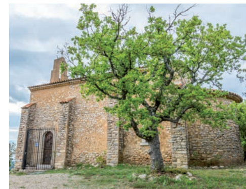
Chapelle Saint-Damas vue depuis le sud
