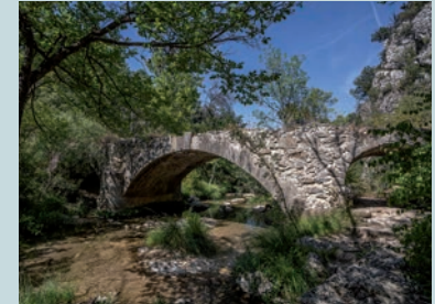
L'ancien pont sur l'Argens
