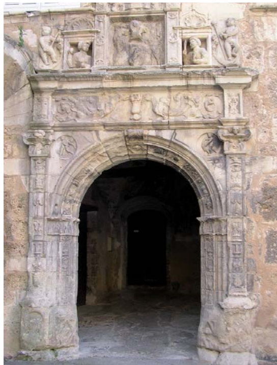
Porte de l'hôtel des Pontevès à Barjols (1532).
