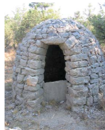
Puits couvert à Varages.
