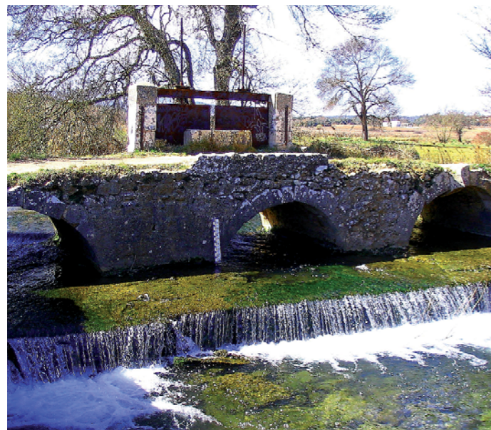
Le pont de l'arrosage à Seillons Source d'Argens.
