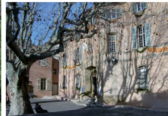
Ancien hospice de Barjols devenu Maison régionale de l'Eau.
